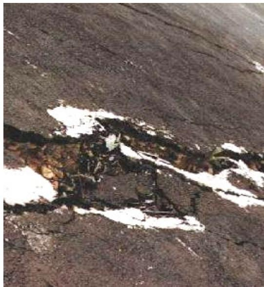
當坡面出現同方向且成群成組的裂縫或局部陷落時，或路面出現方向一致之長裂縫或陷落時，表示地層可能產生滑動，或地底已發生淘空現象。也有可能是因為溫度變化產生的乾裂現象。前者情況較嚴重，後者不會有立即危險但仍應以填縫料填補，以防止滲水軟化土壤。
