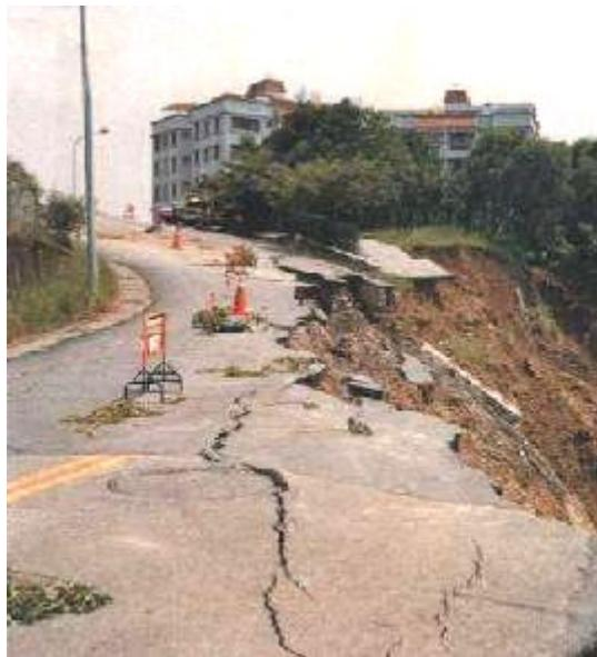
座落於山谷邊緣或大墳土崖邊的房屋，最大特色是基地附近通常有石壁或較高陡的墳土擋土牆。若為石壁且岩體完整未風化，則應較無安全顧慮；反之，若為破碎風化岩體或高陡的墳土擋土牆，則住戶應該常常檢視居家周圍台地、道路及邊坡，時時注意有無不良癥兆。
