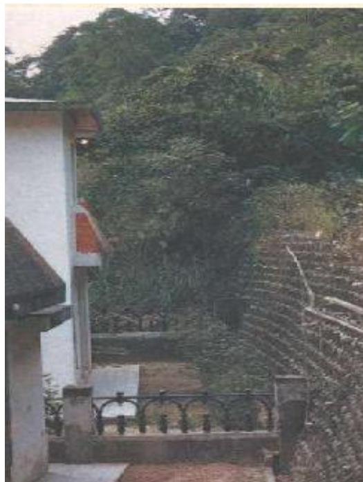
除非有其他安全防護措施，房屋建築之任何一個牆面與擋土牆間應保持擋土牆高度一半以上之距離才符合長期安全的需求。
