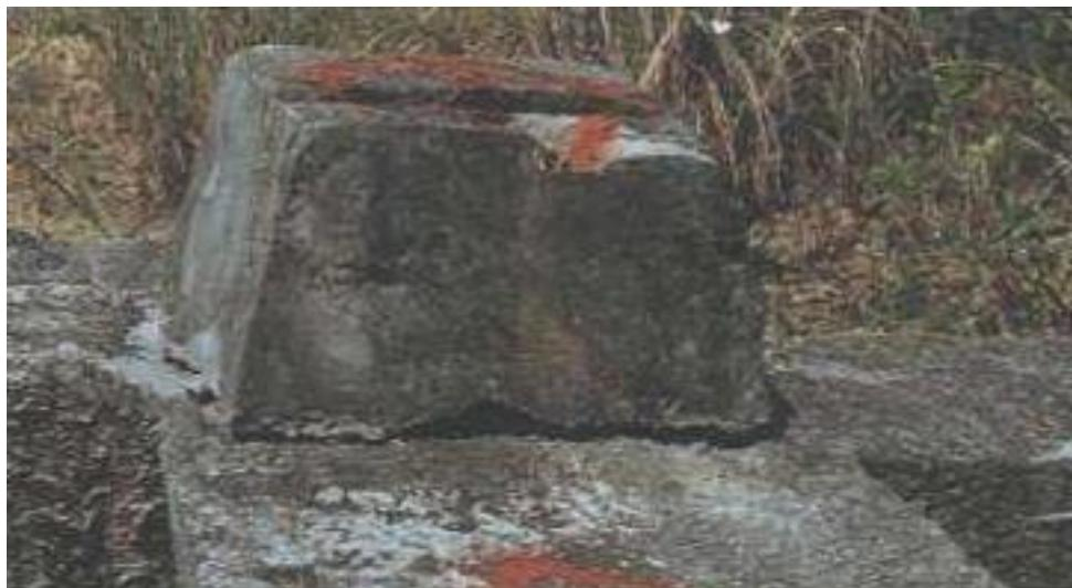
當地錨錨頭與擋土牆發生開裂或剝離時，表示該地錨可能因施工不良或邊坡滑動而喪失效用了。
