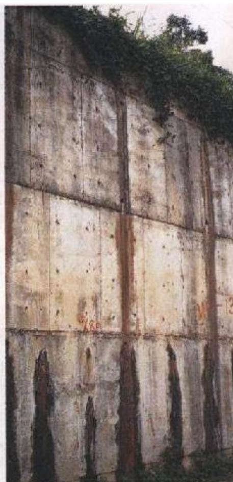
若擋土牆的排水孔無法正常出水，或者排水混濁帶泥，則可能是擋土牆的排水不佳，或牆背回填土淘空，為潛在危機之一。
