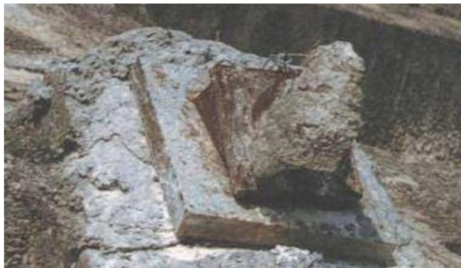
當錨頭處發現銹蝕現象，表示錨頭將逐漸失去 應有的設計標準，未來有夾片脫落或錨頭被拉斷而失去抵抗力之虞。
